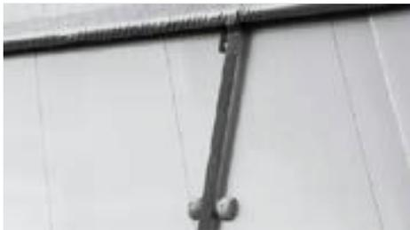
Führung des Spanngurtes aus Kunststoff.
