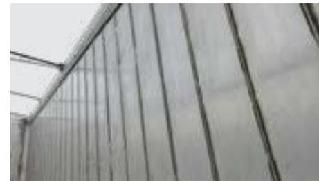
Um die höchste Beständigkeit zu gewährleisten, werden die Profile der Seitenwände über ihre ganze Höhe geschweißt.
