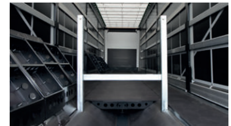
Pfosten zur Sicherung der Stahlspulen
